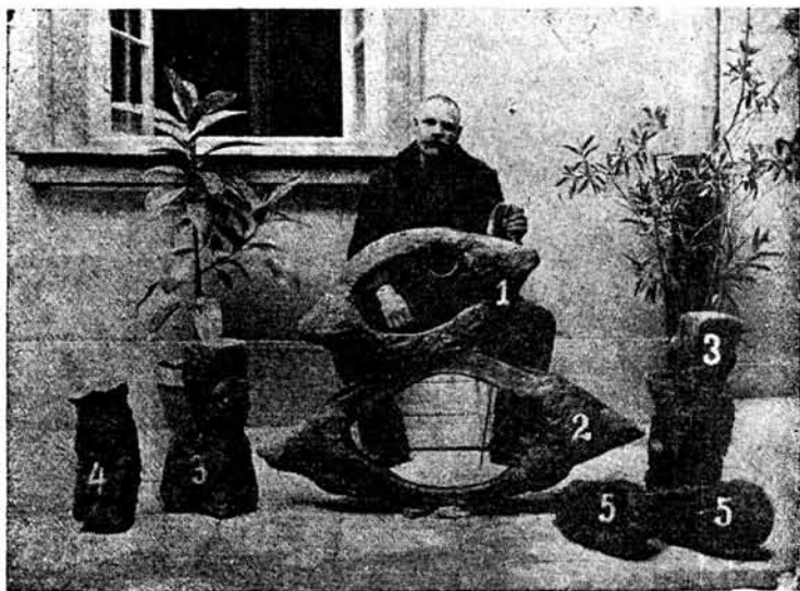
Обр. 2. Чук (1), скрига (2), железните части на двете расофи (3), наковалня (4) от сѝмоков в с. Тешово, Гоце Делчевско, и двете поло- вини на един неков (5) от сѝщото село, с Петър Н. Табаков — само- ковар от Горно Броди, живеещ сѝга в с. Тешово, изработил модела на самокова
